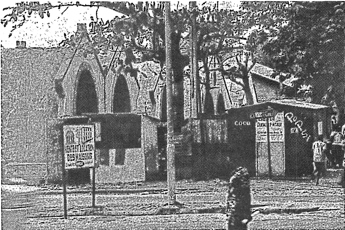
40 – Boulevard Kasavubu : un habitat expérimental, en béton coulé (expérience non suivie). Remarquez les petites boutiques parasitant l'espace public. (R.M.)
