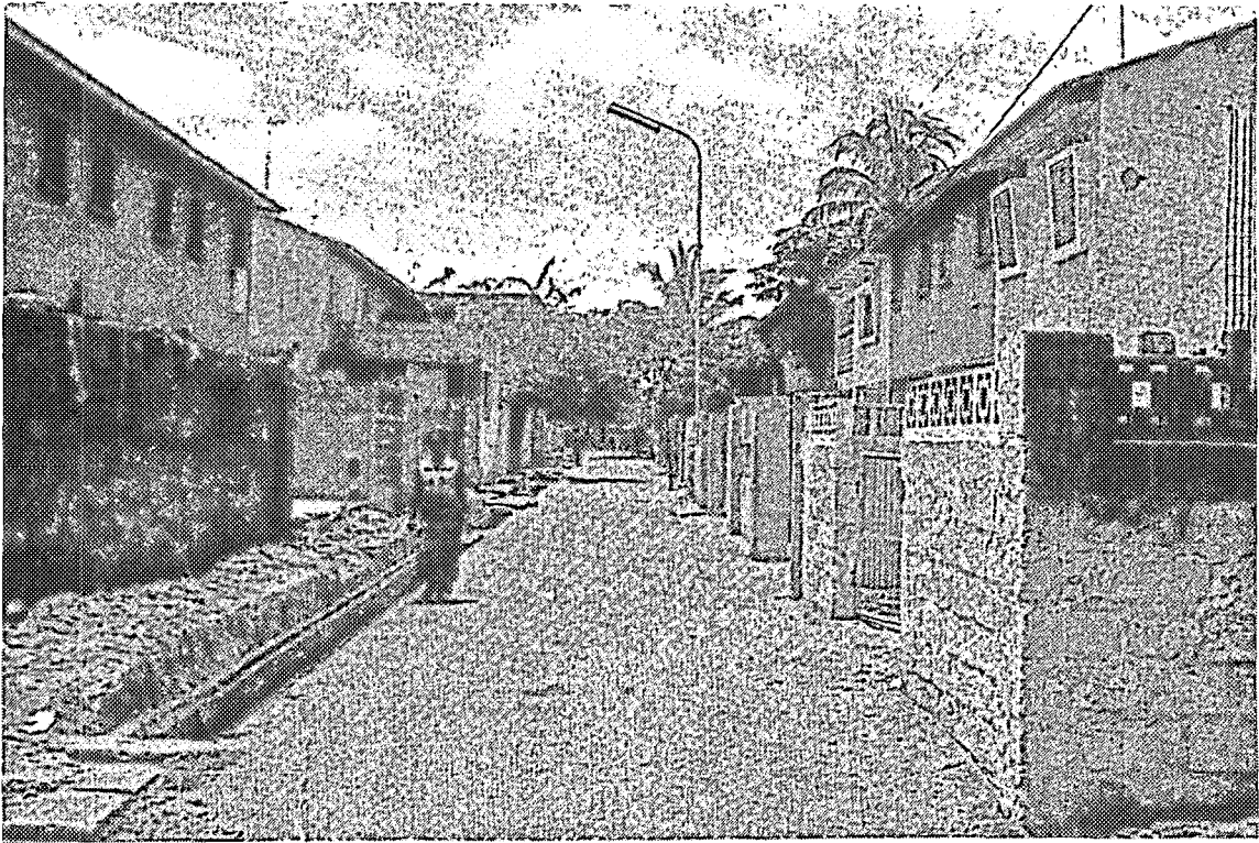
35 – Une rue de desserte intraquartier à Bandalungwa. Les Kinois actuels ont ajouté les murs de parpaings et les grilles (appelées «antivols») qui ferment les entrées de maison. (C.J.)
